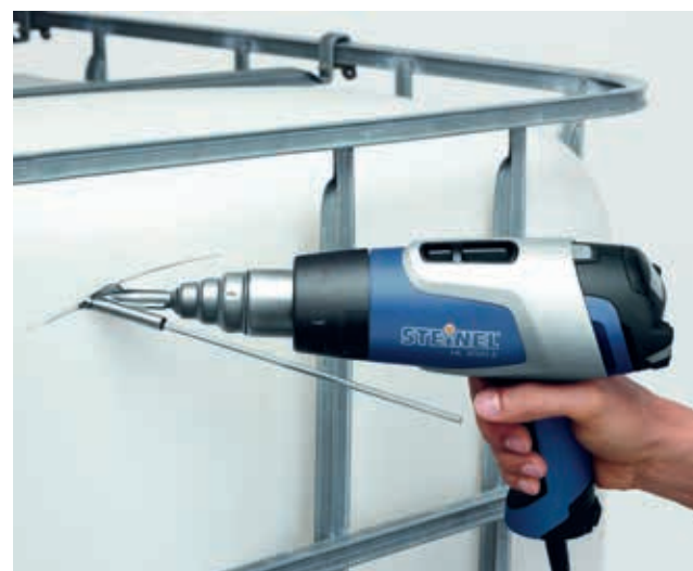
Reparera. Svetsa PVC-vattentankar.
